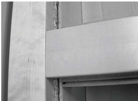
slika br.8 postavljanje poprečnika
