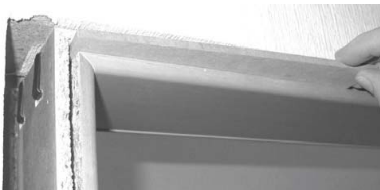
slika 17 – zaštita utora prije stavljanja klinova ( kajli)
