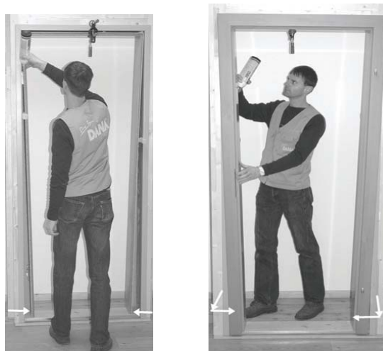
slika 22; nanošenje pjene na postojeći metalni dovratnik
